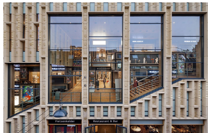
Afbeelding 17: Goede visuele verbinding tussen binnen en buiten.
