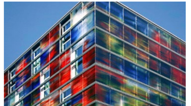
Afbeelding 23: Door aan zowel de voorzijde als de achterzijde uit te breiden ontstaat de mogelijkheid de huidige gesloten gevelarchitectuur te transformeren. Voor de hand liggend is veel meer transparantie en kleur in het gevelbeeld toe te voegen.
