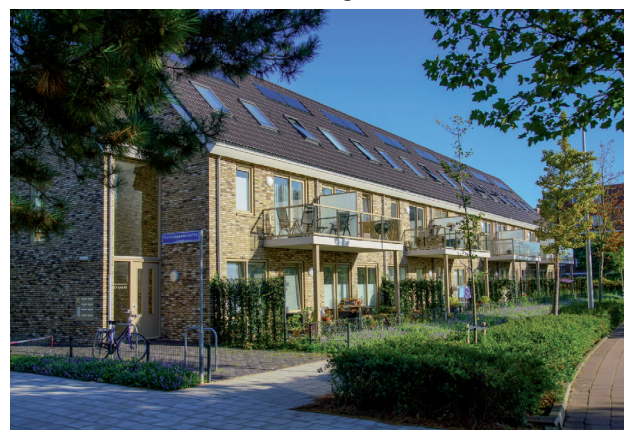
^ referentie Beneden-bovenwoningen woningbouwvereniging St. Antonius van Padua Noordwijkerhout (kdvk architecten)
