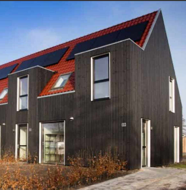
RIJENWONING MET EEN DUURZAME PLUS
