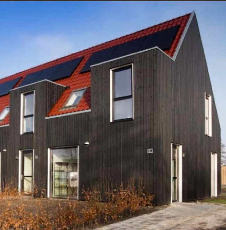
RIJENWONING MET EEN DUURZAME PLUS
