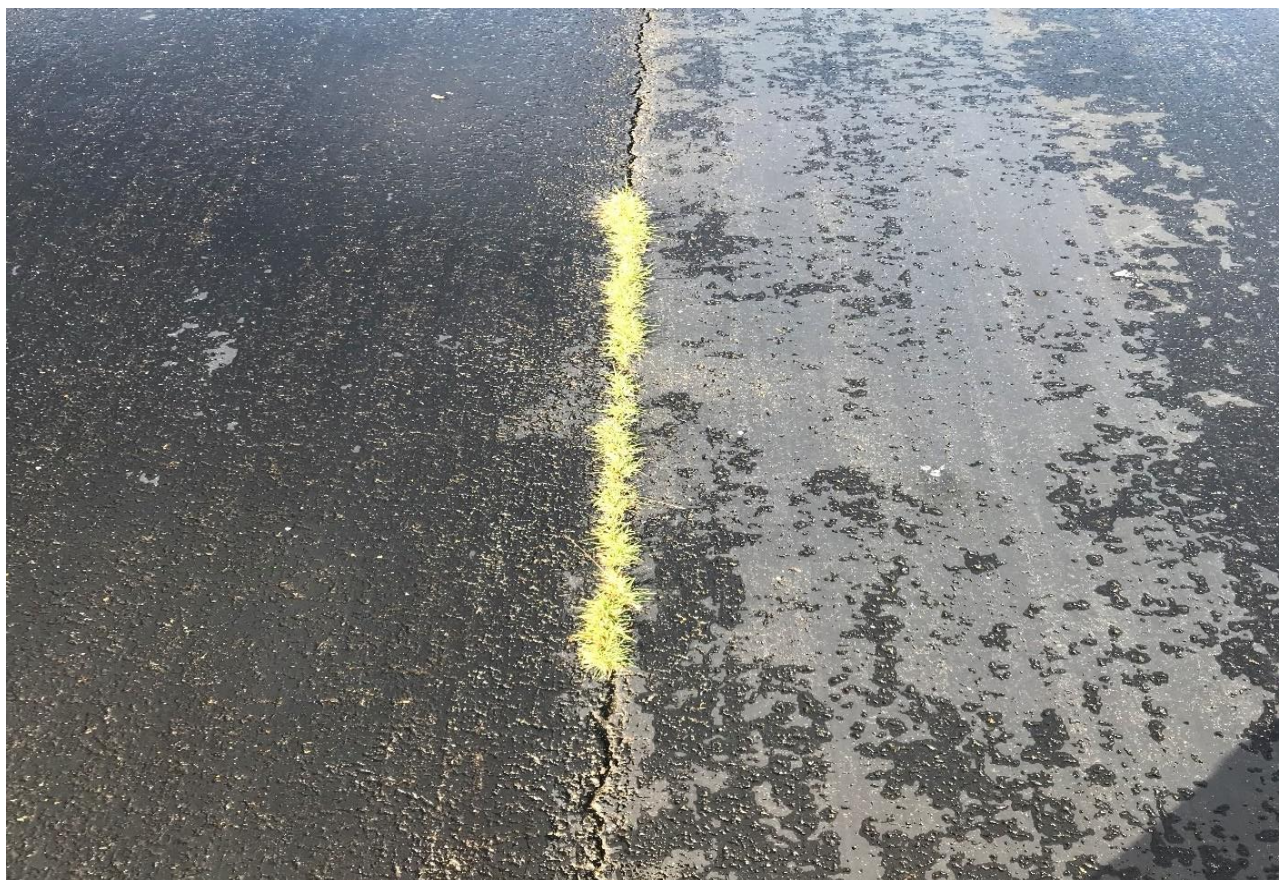
Langsscheuren met onkruid in het midden van de start/landingsbaan
