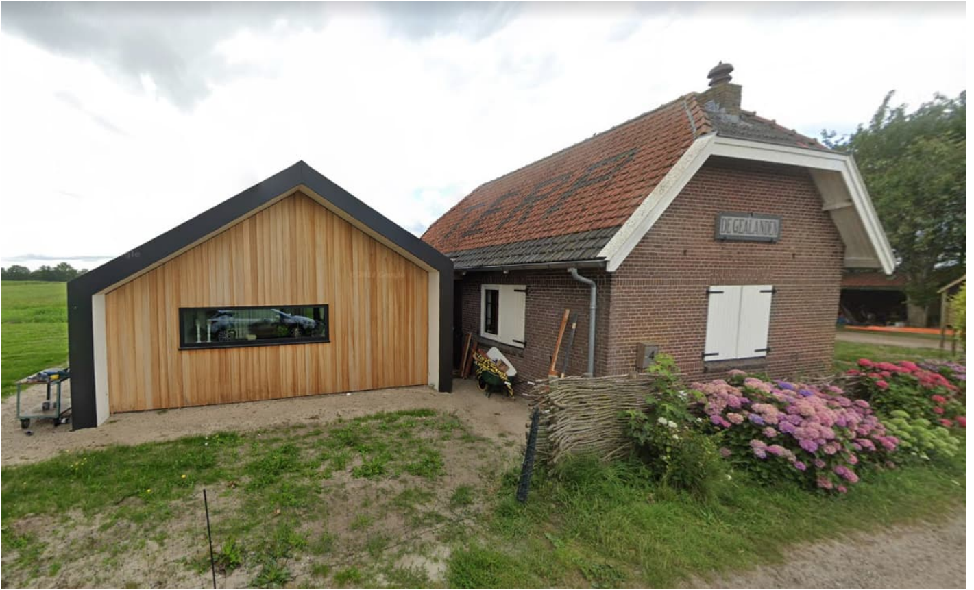
Figuur 8-5 Voormalig gemaal, Gealânswei 4
