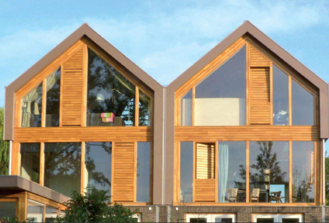
DUBBELE WONINGEN IN HOUT EN GLAS
